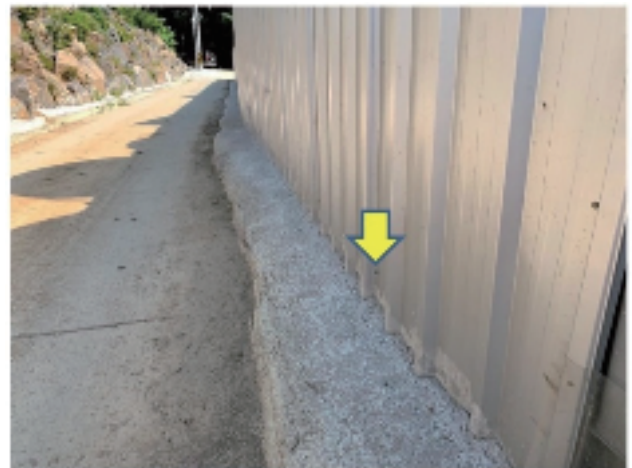
写真6 フェンス下部はしっかりコンクリートで固められ小動物の侵入防止とイノシシが鼻で持ち上げることはできない状態（資料提供：大韓韓豚協会）
