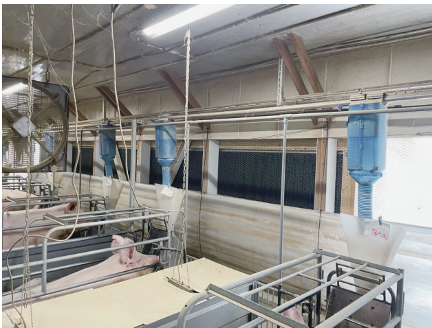
図14 (株)みずのクーリングパッド設置内観
