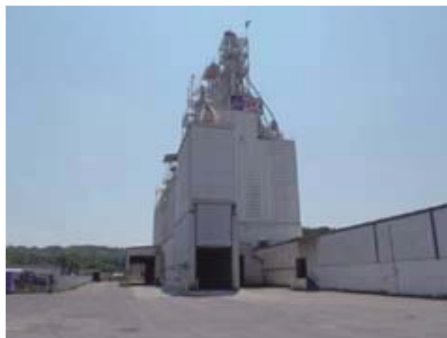
Big Gainの工場の外観
